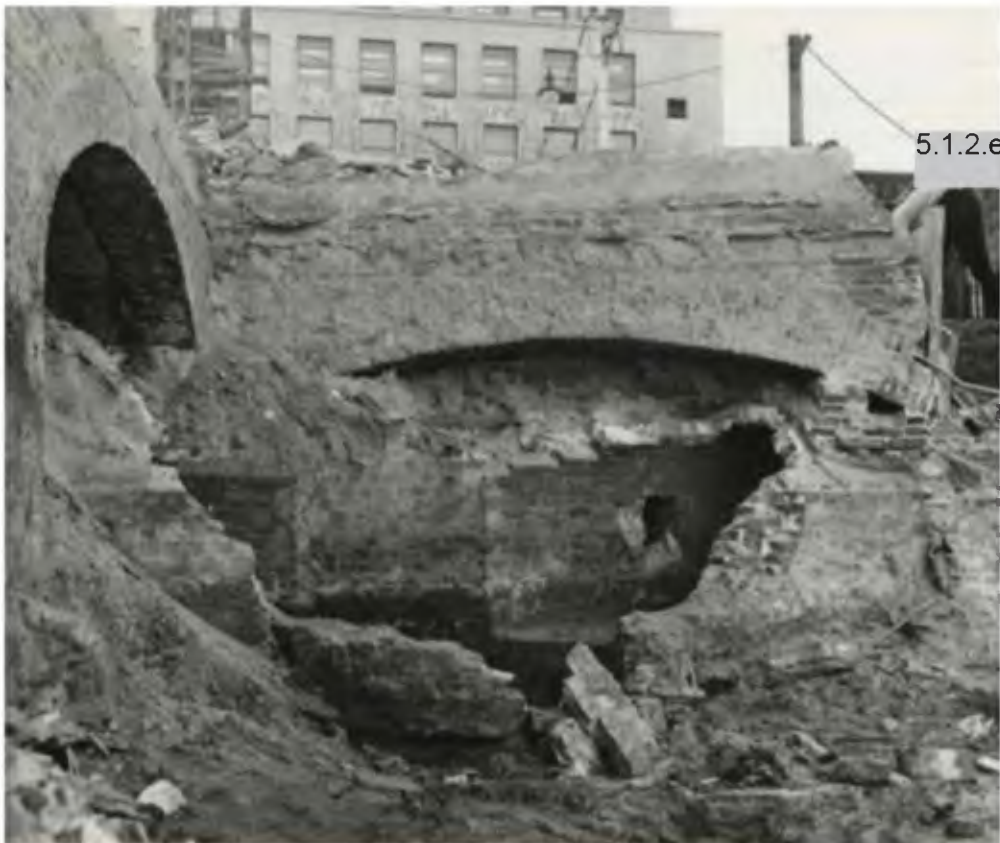
Afb. 4.37 Overkluizing van de Hofgracht, aangetroffen tijdens werkzaamheden in 1960-1963 (Rijksdienst Cultureel Erfgoed).
