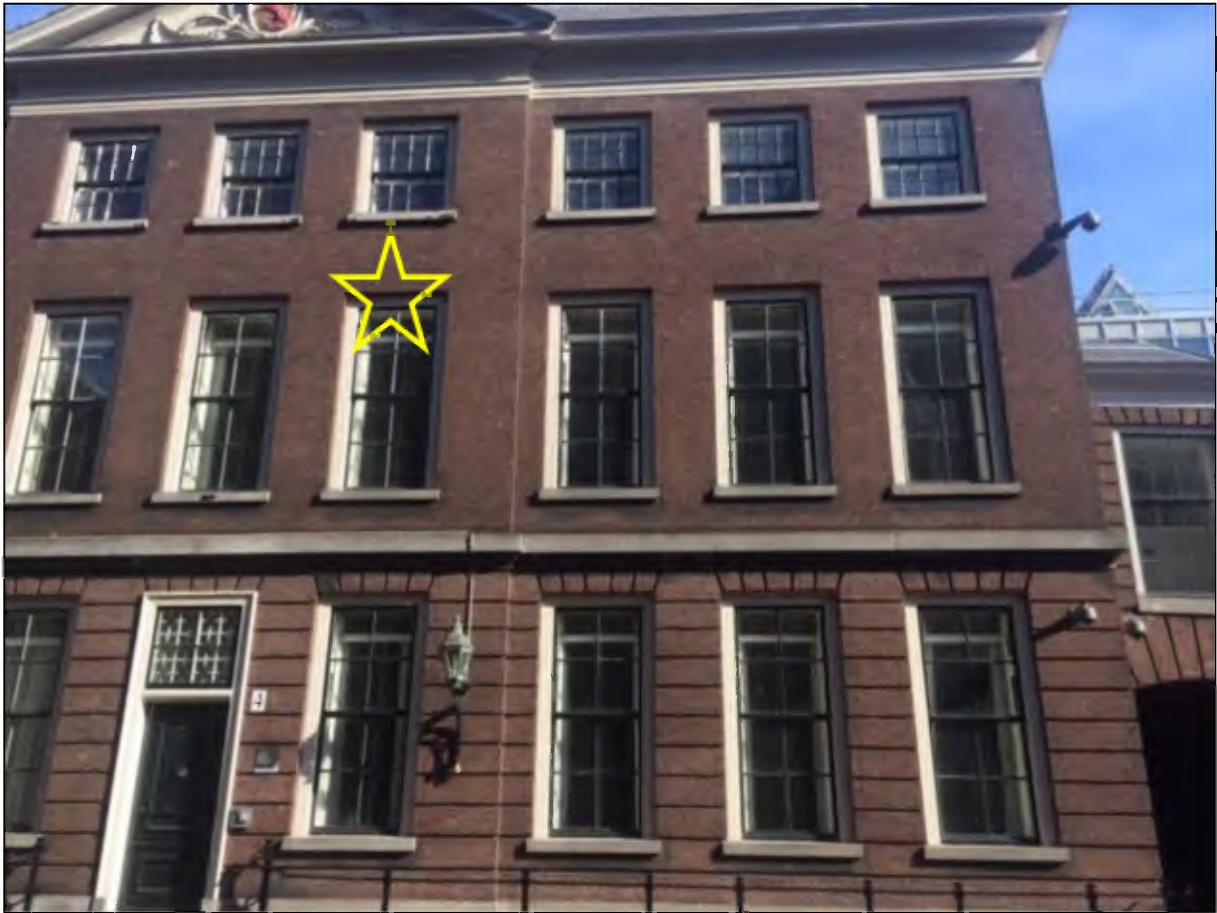
Figuur 14. Tijdens het veldbezoek van 31 mei waren er twee foeragerende gewone dwergvleermuizen die aanvlogen en gebouw B aantikten bij de 1e verdieping bovenaan het 4e raam van rechts (zie gele ster).
