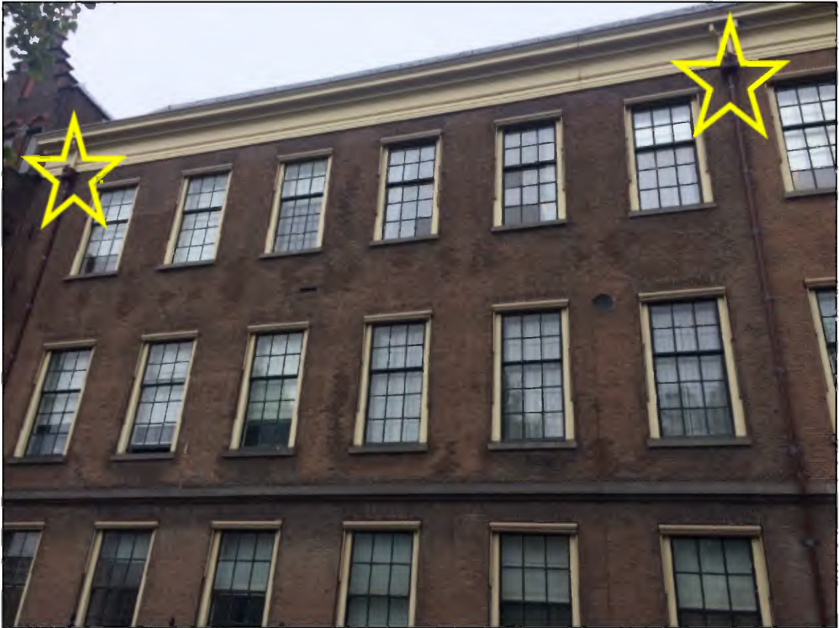
Figuur 33. Om 02:00 uur werd er gezwermd door gewone dwergvleermuizen bij 3 regenpijpen (met name de middelste, rechts op deze foto) aan de westkant van de Tweede Kamer.
