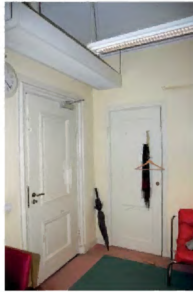
TK-B-117 Interieur B.02.0.03, gezien richting het noordoosten, met paneel-deur met geprofileerde omlijsting naar de gang uit de bouwrijd.
