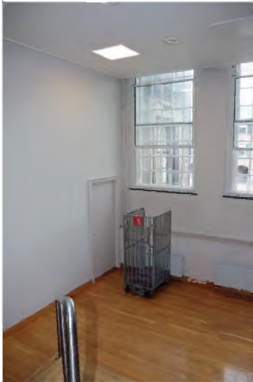
TK-A-748 Interieur verkeersruimte A.00.1.11 (voorheen smalle huis), gezien in noordelijke richting. In de noordwand twee vensters met schuiframen; verlaagd plafond. Links in de hoek ingebouwde kast.
