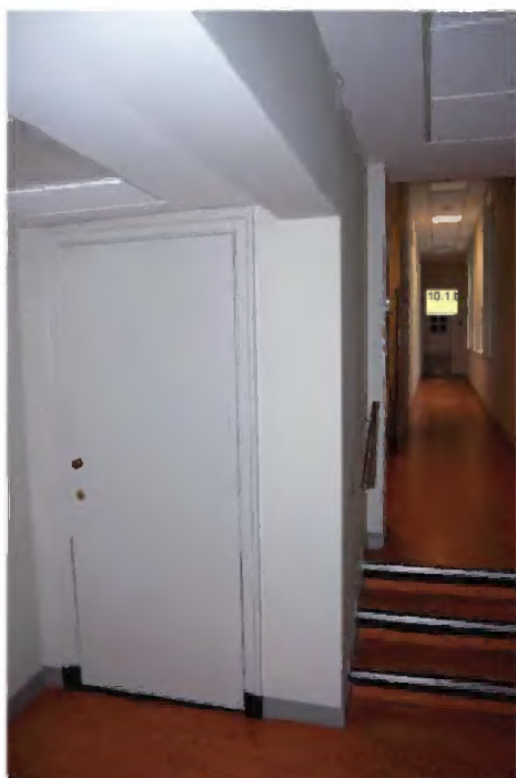
TK-A-819 Interieur gang met systeemplafond, gezien in westelijke richting naar het voormalig gebouw van Landsdrukkerij, links deur van werk-kast.
