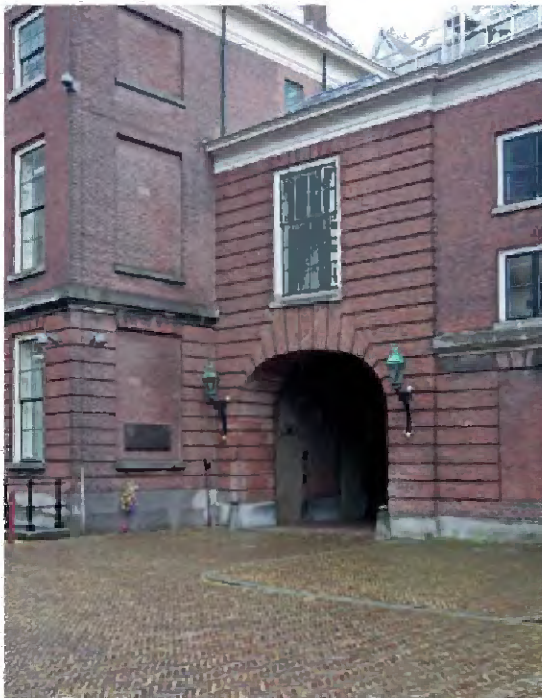
TK-A-831 Voorzijde (Binnenhof) van de Hofpoort, uitgevoerd in 'rustica' aan weerszijden van de doorgang met een zogeheten Florentijnse boog, een hardstenen schamppaal en een gietijzeren lantaarn met koperen dakje.
