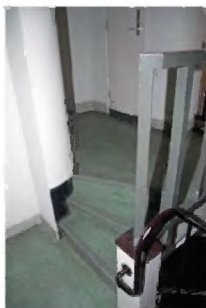
TK-A-811 Interieur trappenhuis ter hoogte van de eerste verdieping; het bovenste deel van de trap is vernieuwd, dan wel toegevoegd en voorzien van een metalen traphek.
