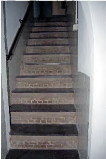
TK-B-30 Trap met hardstenen opdektrappen en lambrisering van witte tegels naar de begane grond.
