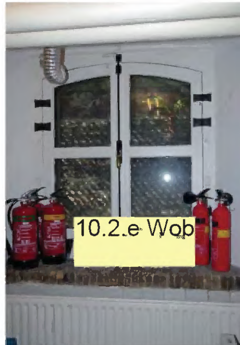
TK-B-40 Kelderlicht met vinderscharnieren en op het kozijn wit geschilderde ijzeren beugels voor afsluitbalken.
