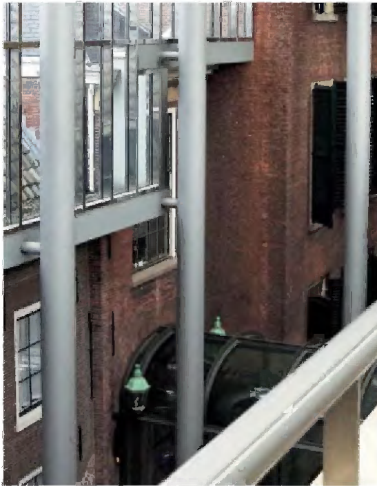
TK-A-833 De zuidgevel van de Hofpoort is sober uitgevoerd zonder 'rustica'. Aan weerszijden van de doorgang een gietijzeren lantaarn met koperen dak.
