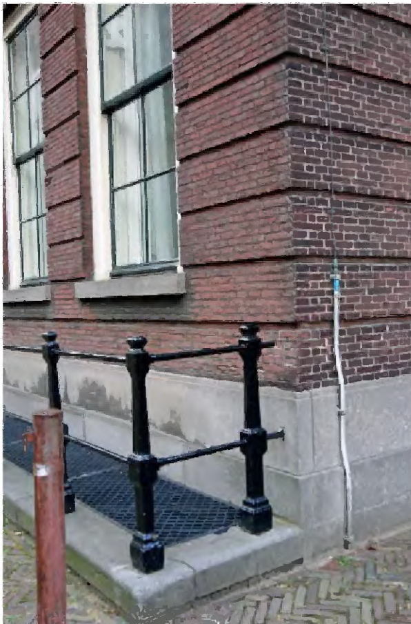
TK-B-5 Voor het gebouw ligt een smalle stoep met ijzeren roosters van de kelderkoekelken, afgezet met een eenvoudige gietijzeren hekwerk.
