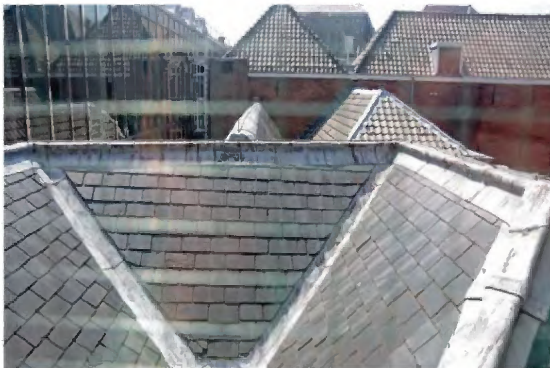
TK-A-837 Dak van de Hofpoort, gezien vanuit het Comptoir-Generaal.
