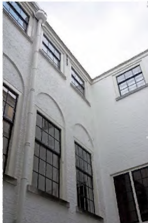
TK-A-710 Binnenplaats, gezien in zuidwestelijke richting. De gevel aan de zuidzijde van de binnenplaats bevat op de eerste verdieping hoge vensters met roeden schuiframen onder een boogveld; op de tweede verdieping kleine vensters met 9-ruits schuiframen.
