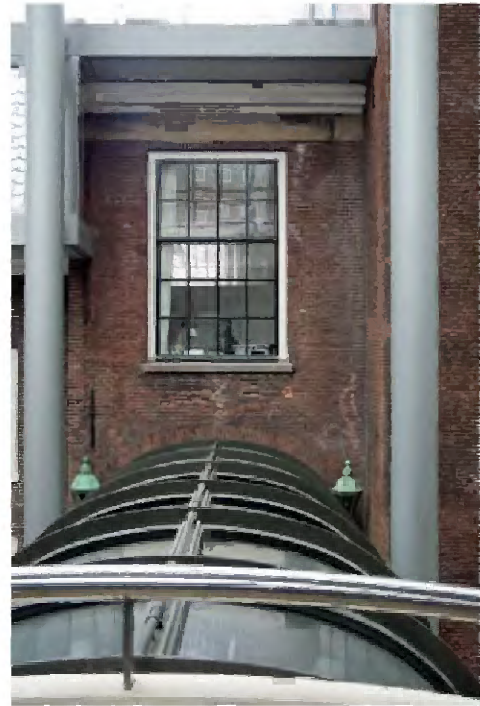
TK-A-834 Boven de poortdoorgang bevindt zich net als aan de voorzijde een groot venster met roeden schuifraam.
