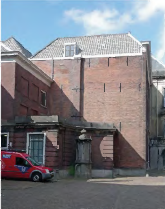
TK-A-696 Blind uitgevoerde oostgevel met uitgebouwd rookkanaal.
