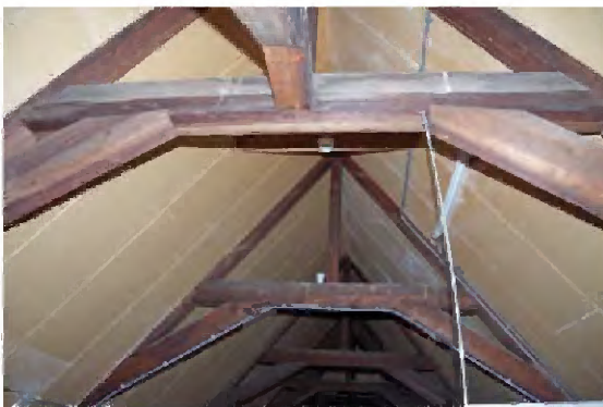
TK-A-782 Interieur zolder (kapruimte), gezien in oostelijke richting.
