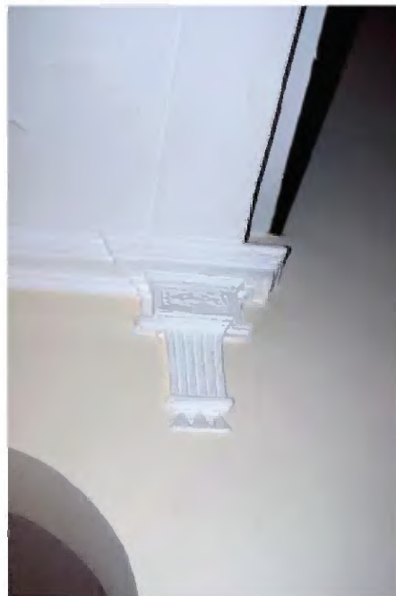
TK-B-103 Overgang naar het zuidelijk deel van de middengang met de trap met een van de stucwerkconsoles aan weerszijden van het trapgat.
