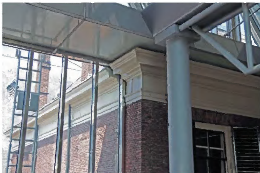
TK-B-9 Detail west- en zuidgevel met omlopende kroonlijst.
