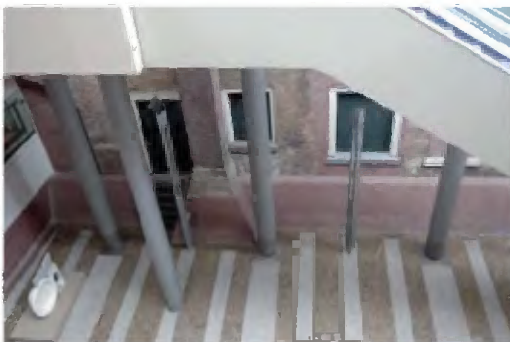
TK-A-703 en TK-A-704 Kelderverdieping op uitgemetselde voet (fundering) aan de zuidzijde met vierkante vensteropeningen en kelderingang.
