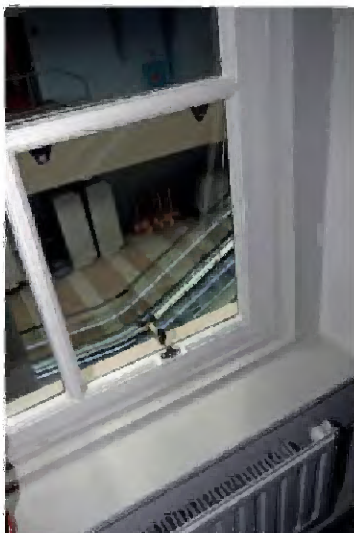
TK-A-809 Detail van het vernieuwde raam in de zuidwand.
