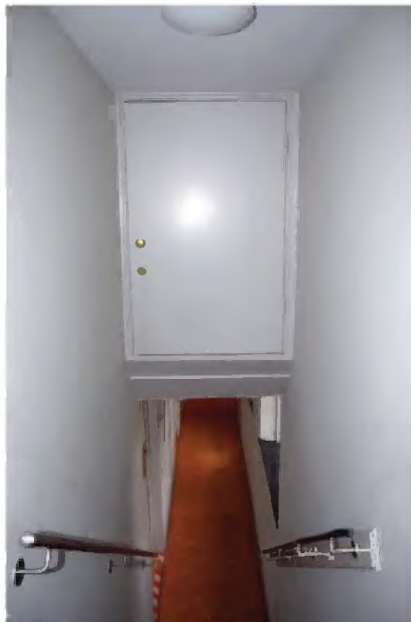
TK-A-818 Oostelijk uiteinde van de gang, gezien in westelijke richting vanuit de Hofpoort. Via het luik boven de trap is de ruimte op de tweede verdieping boven het zuidelijk deel van het Pompgebouw bereikbaar.
