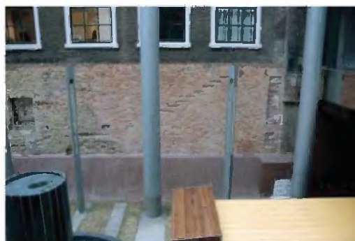
TK-A-793 Zuidgevel op kelderniveau met bouwsporen van een trap naar de begane grond rechts van dichtgezetten vensteropening.
