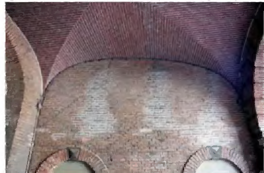
TK-A-836 Aansluiting van het gewelf op de zijgevel van Comptoir-Generaal.
