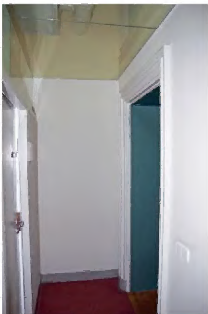
TK-B-85 Interieur van het portaal, afgescheiden van ruimte B.01.0.06, gezien in oostelijke richting, met rechts de oorspronkelijke deur met omlijsting naar de gang en links de nieuwe scheidingswand met toegangsdeur naar het vertrek. De ruimte is overdekt met glas (lager dan het oorspronkelijke stucwerkplafond).
