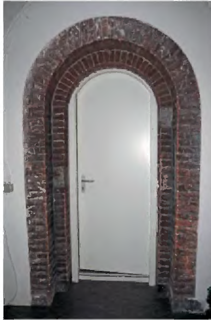
TK-B-29 Gemetseld deurkozijn met moderne deur (verbinding met ruimte B-1.0.-08).
