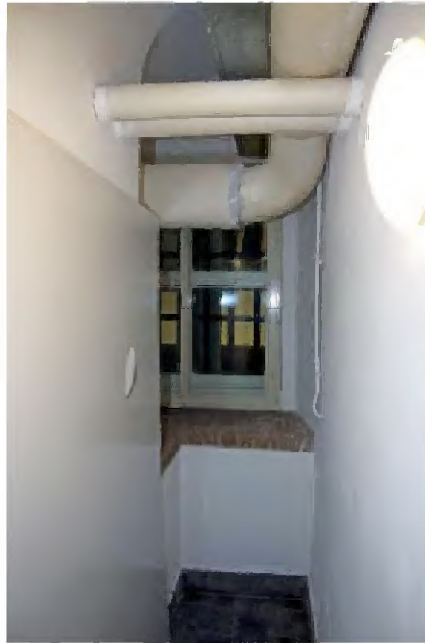
TK-B-31 Nis naast de trap met kelderlicht in de zuidgevel.
