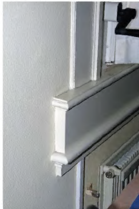
TK-B-65 Detail vensteromlijsting (anders dan in B.00.0.6).
