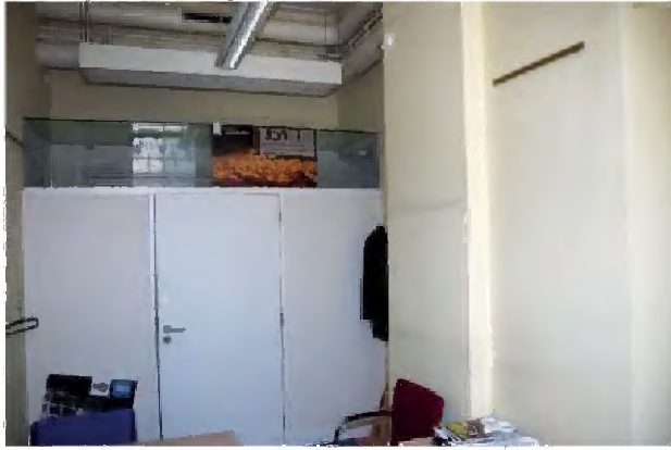
TK-B-86 Interieur van vertrek B.01.0.06, gezien in zuidelijke richting, met nieuwe scheidingswand met deur naar het portaal, overdekt met glas. Rechts rookkanaal met aansluitende kastenwand.
