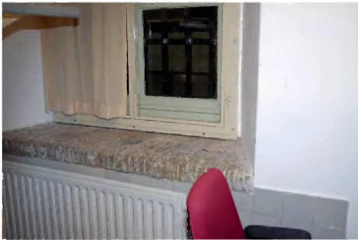
TK-B-17 Diepe vensterinis aan de zuidzijde in B-1.0.02.
