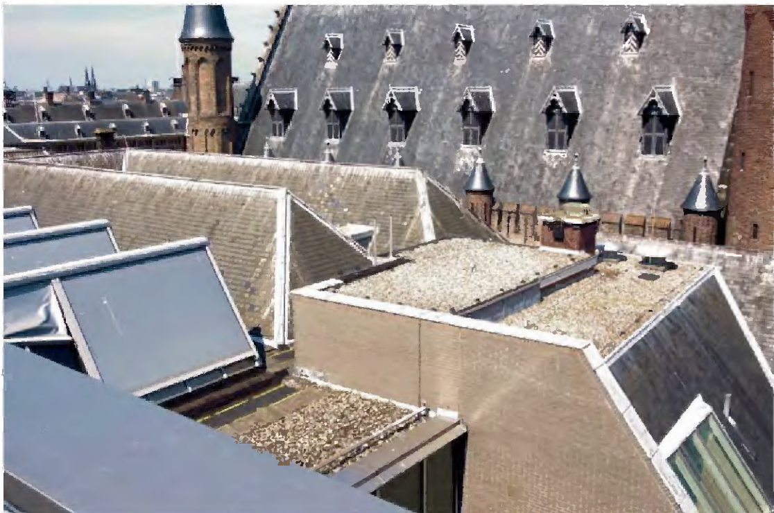
TK-B-11 Dakenlandschap, gezien vanuit het zuidoosten, met links het U-vormig dak van het voormalige kantoor van het Comptoir-Generaal en rechts op de voorgrond het dak van de hal in het Schepelgebouw.
