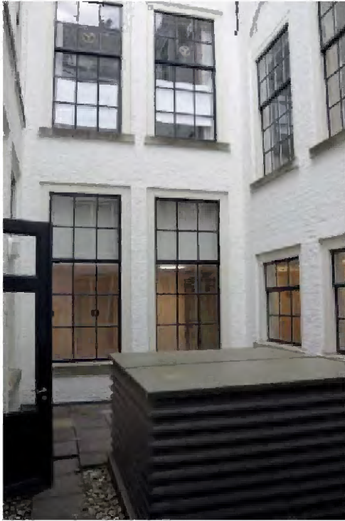
TK-A-708 Binnenplaats, gezien in zuidoostelijke richting. De gevel aan de oostzijde bevat op de begane grond hoge vensters met schuiframen vergelijkbaar met die in de gevel aan de noordzijde van de binnenplaats. De gevel aan de zuidzijde bevat op de begane grond kleine vensters met 9-ruits schuiframen en op de eerste verdieping hoge vensters met roeden schuiframen onder een boogveld.
