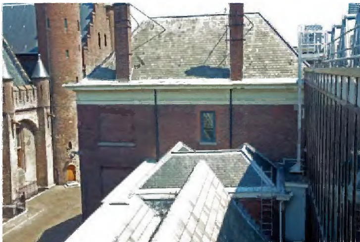
TK-B-8 Westgevel, gezien vanuit het gebouw van de Landsdrukkerij.
