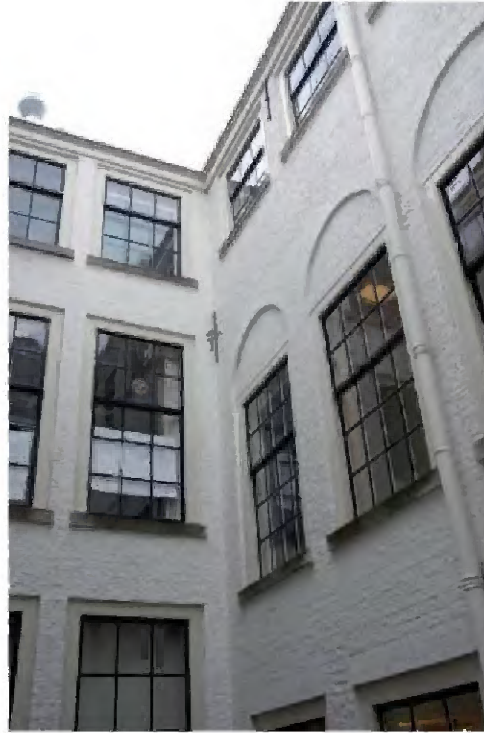
TK-A-709 Binnenplaats, gezien in zuidoostelijke richting; de gevel aan de zuidzijde bevat op de tweede verdieping kleine vensters met 9-ruits schuiframen.
