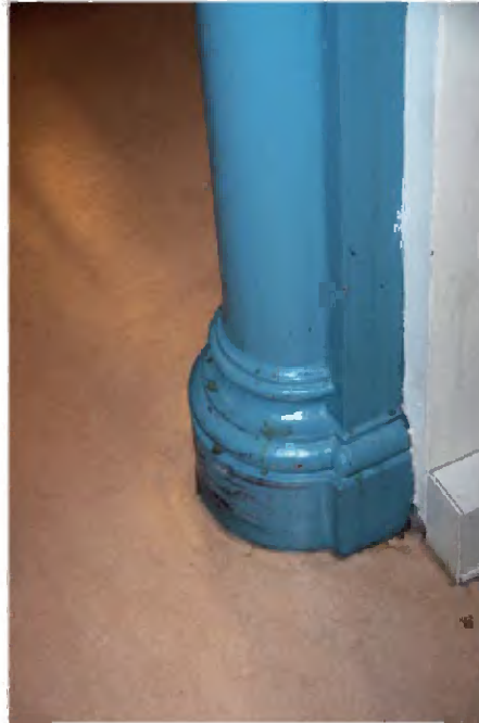
TK-B-46 Detail voet gietijzeren kolom.
