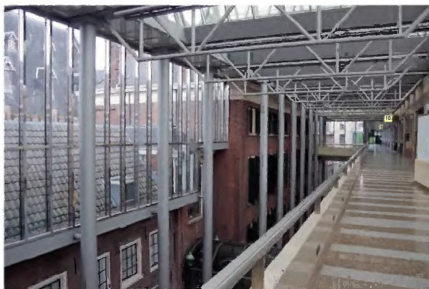
TK-B-10 Zuidgevel aan overdekte ruimte (Schepelhal) tussen gebouw TK-B en TK-N. Het deel links van het midden met de groene louvreliken is de achtergevel van het Comptoir-Generaal.
