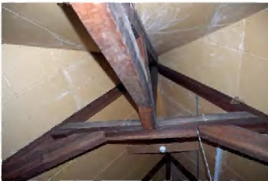
TK-A-783 Interieur zolder (kapruimte), gezien in oostelijke richting, met in het noordelijk dakvlak een dakkapel.
