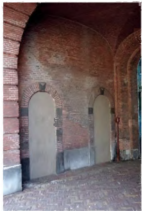
TK-B-7 Dichtgezette sierdoorgangen in de westgevel bij de Hofpoort.
