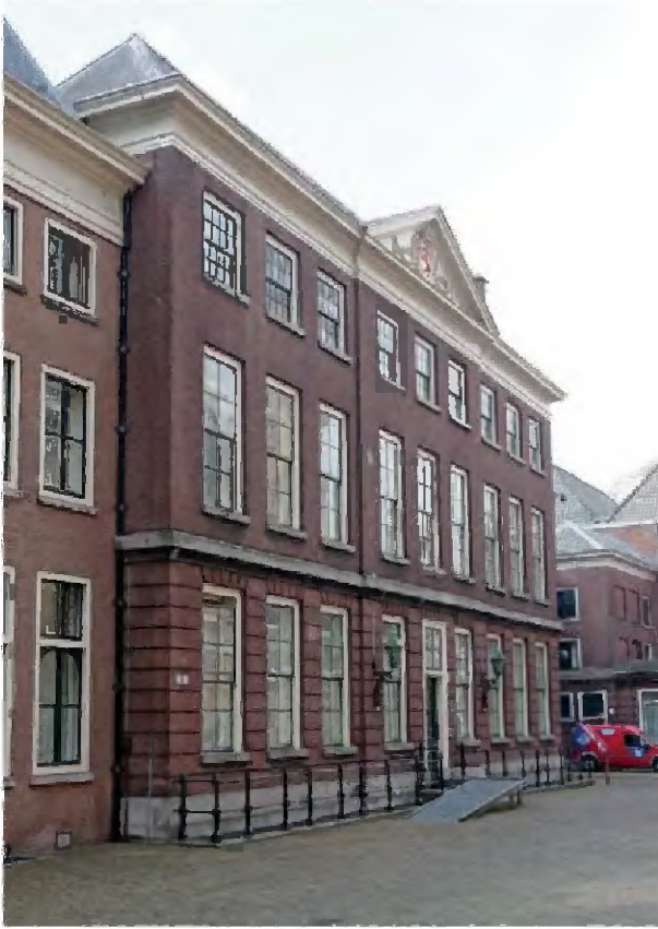
TK-B-2 Noordgevel, gezien vanuit het noordoosten. De oostgevel gaat grotendeels schuil achter het in 1973 herbouwde Schepelgebouw.
