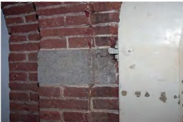
TK-B-20 Hardstenen blok met scharnier.
