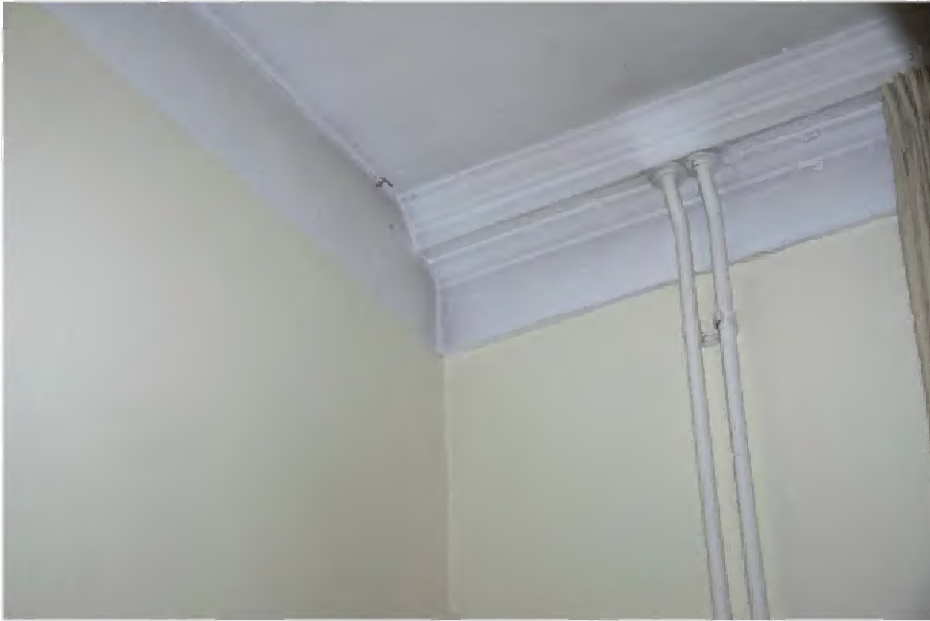
TK-B-70 Detail stucwerkplafond. Zichtbaar is dat het plafond doorloopt naar het aangrenzende vertrek B.00.0.07; de scheidingswand tussen beide vertrekken is later geplaatst.
