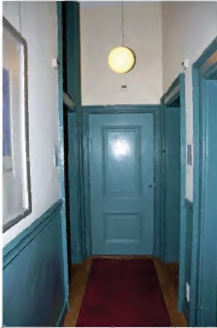
TK-B-100 Westelijk uiteinde van gang B.01.0.10a met van de gang afgeschel- den werkkast (oorspronkelijk toilet); links toegang tot B.01.0.04.
