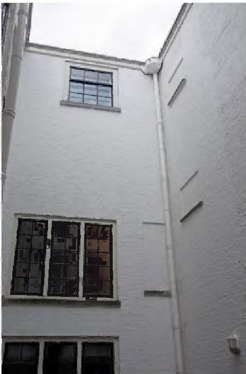
TK-A-706 Noordwesthoek van de binnenplaats met in de gevel aan de westzijde van de binnenplaats op begane grond en eerste verdieping een groot 3-lichtvenster; op de eerste verdieping is er tevens een smalle blinde venster nis; op de tweede verdieping een klein venster met 9-ruits schuifraam. Het westelijk deel van de gevel aan de noordzijde van de binnenplaats is nieuw opgemetseld en bevat dichtgezet vensteropeningen.
