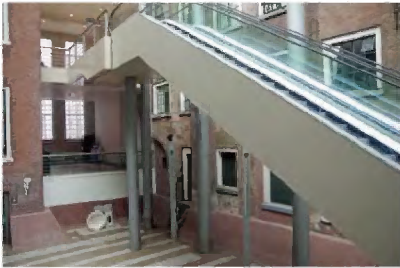
TK-A-699 Onderste zone van de zuidgevel, gezien in zuidwestelijke richting.
