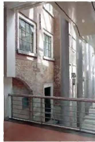
TK-A-702 (r) Op de begane grond zijn ook in het smalle deel, vierkante vensters met vaste 12-ruitjes met enkele ruitjes hebben uitzetijzers.
