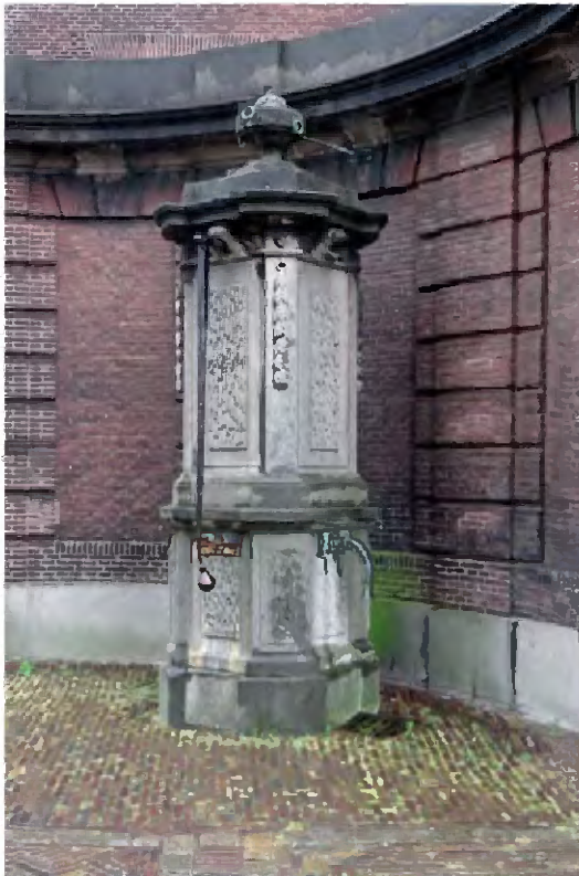
TK-A-787 De hardstenen waterpomp met koperen wateruitlaat (aan twee zijden) en smeedijzeren zwengel.
