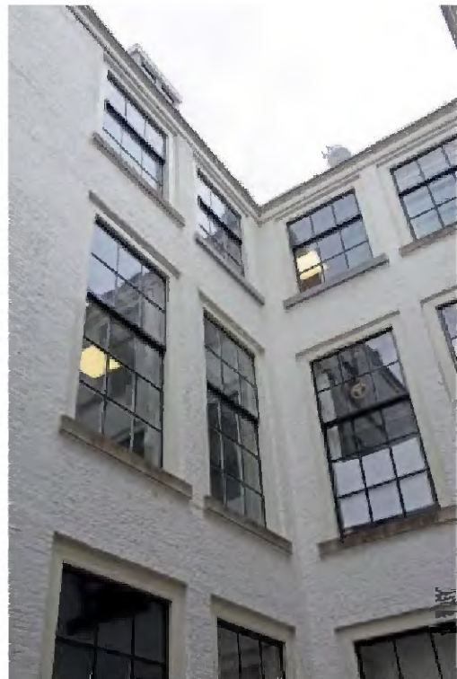
TK-A-707 Noordoosthoek van de binnenplaats. Het oostelijk deel van de gevel aan de noordzijde van de binnenplaats bevat twee vensters op elke verdieping; op de begane grond een hoog venster en een tuindeur en op de eerste verdieping twee hoge vensters, voorzien van 15-ruits schuiframen en op de tweede verdieping kleine vensters met 9-ruits schuiframen. De gevel aan de oostzijde bevat per verdieping ook twee vensters, vergelijkbaar met die in de gevel aan de noordzijde.
