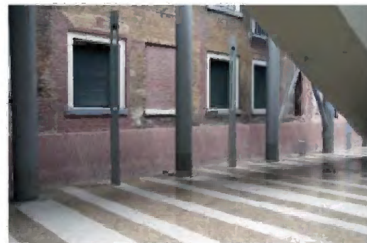
TK-A-703 en TK-A-704 Kelderverdieping op uitgemetselde voet (fundering) aan de zuidzijde met vierkante vensteropeningen en kelderingang.
