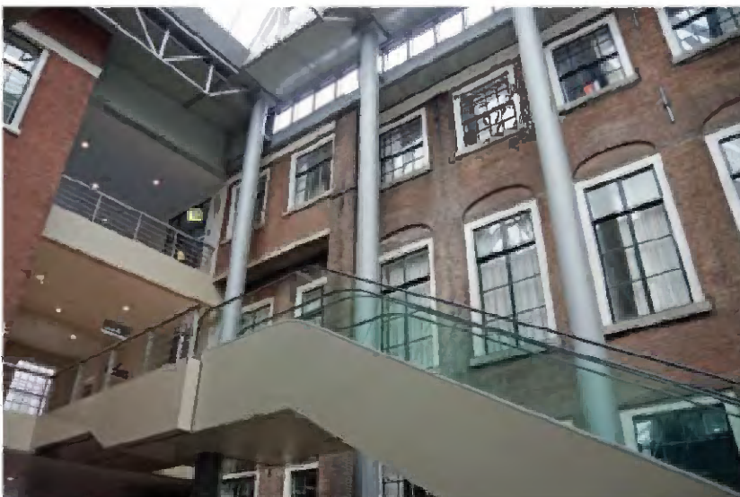
TK-A-698 Bovenste zone van de zuidgevel, gezien in zuidwestelijke richting.
