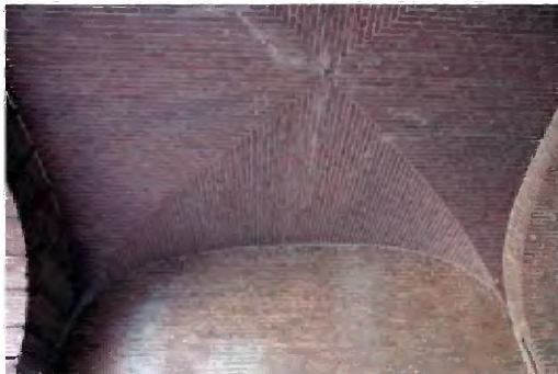
TK-A-835 De poortdoorgang is overdekt met een bakstenen ribloos kruisgewelf, dat in 1890 koud tussen de beide zijgevels van respectievelijk het voormalige Comptoir-Generaal en het Pompgebouw is geplaatst. Aansluiting van het gewelf op de zijgevel van het Pompgebouw.
