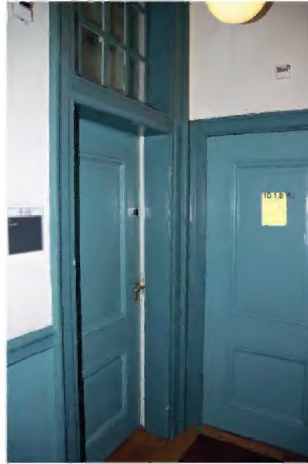
TK-B-101 Toegang tot B.01.0.04; deur met bovenlicht.
