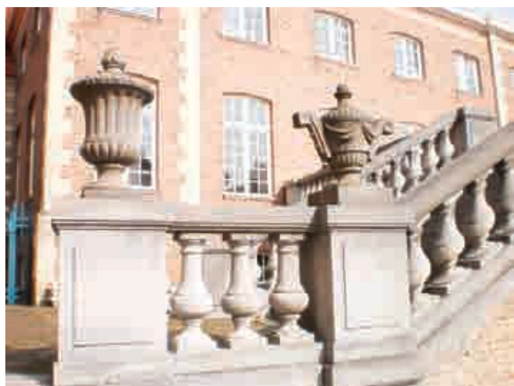
Balustrade met versieringen
