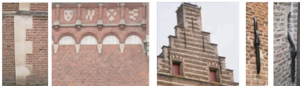
Metselwerk met natuursteen hoekstenen, boogfriezen, gevelafdekking en gevelankers
