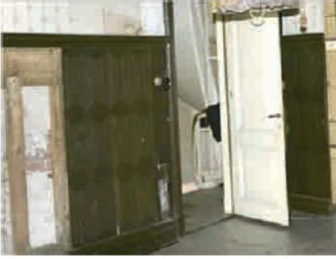
Wandbekleding en lambrisering met beschermlaag van imitatiemarmor van historische waarde in paleis het Loo.
